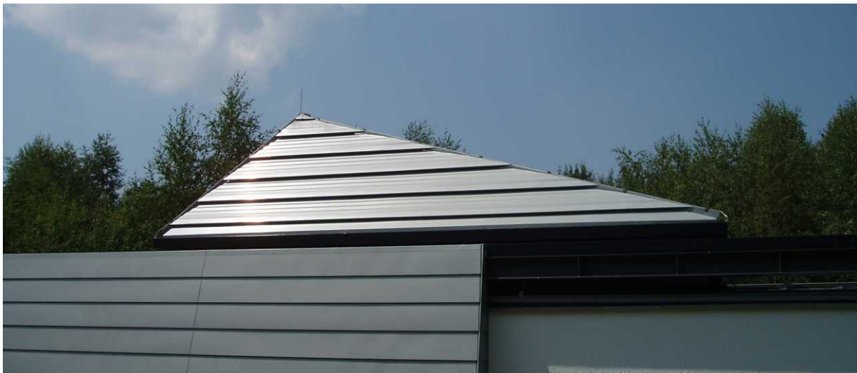
Cabrio -Schiebedach zu etwa 50% geöffnet
