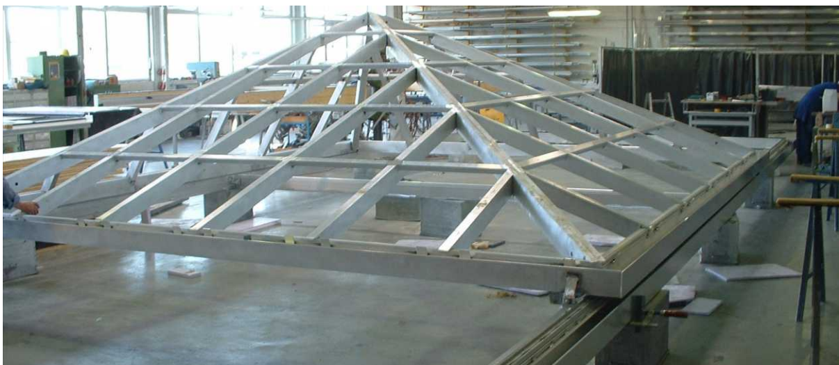
Dachtragwerk im Rohbau (Aluminium-Schweißkonstruktion)
