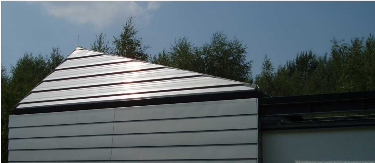
Cabrio-Schiebedach (in asymmetrischer Pyramidenform ) – Zustand geschlossen –
