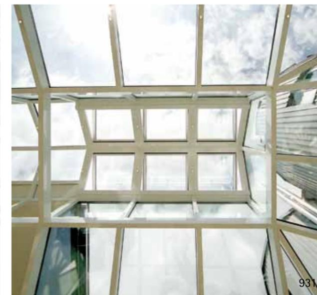
Grazile, exotische Dachkonstruktion mit Laterne- und Dachlüftungsfenstern
