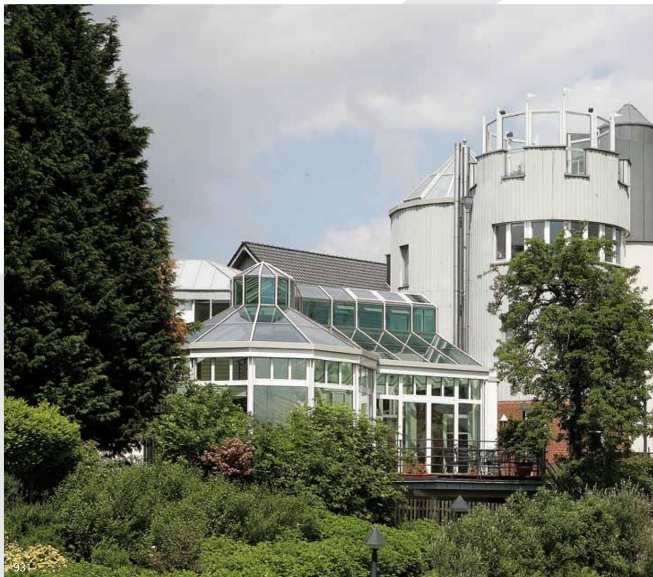
Wintergarten mit selbsttragend geschweißter Dachkonstruktion als filigranes Raumtragwerk ausgeführt
