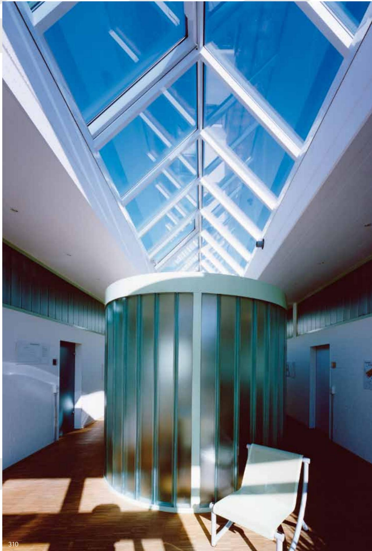
Lichtdach in Satteldachform als geschweißte Aluminiumkonstruktion
