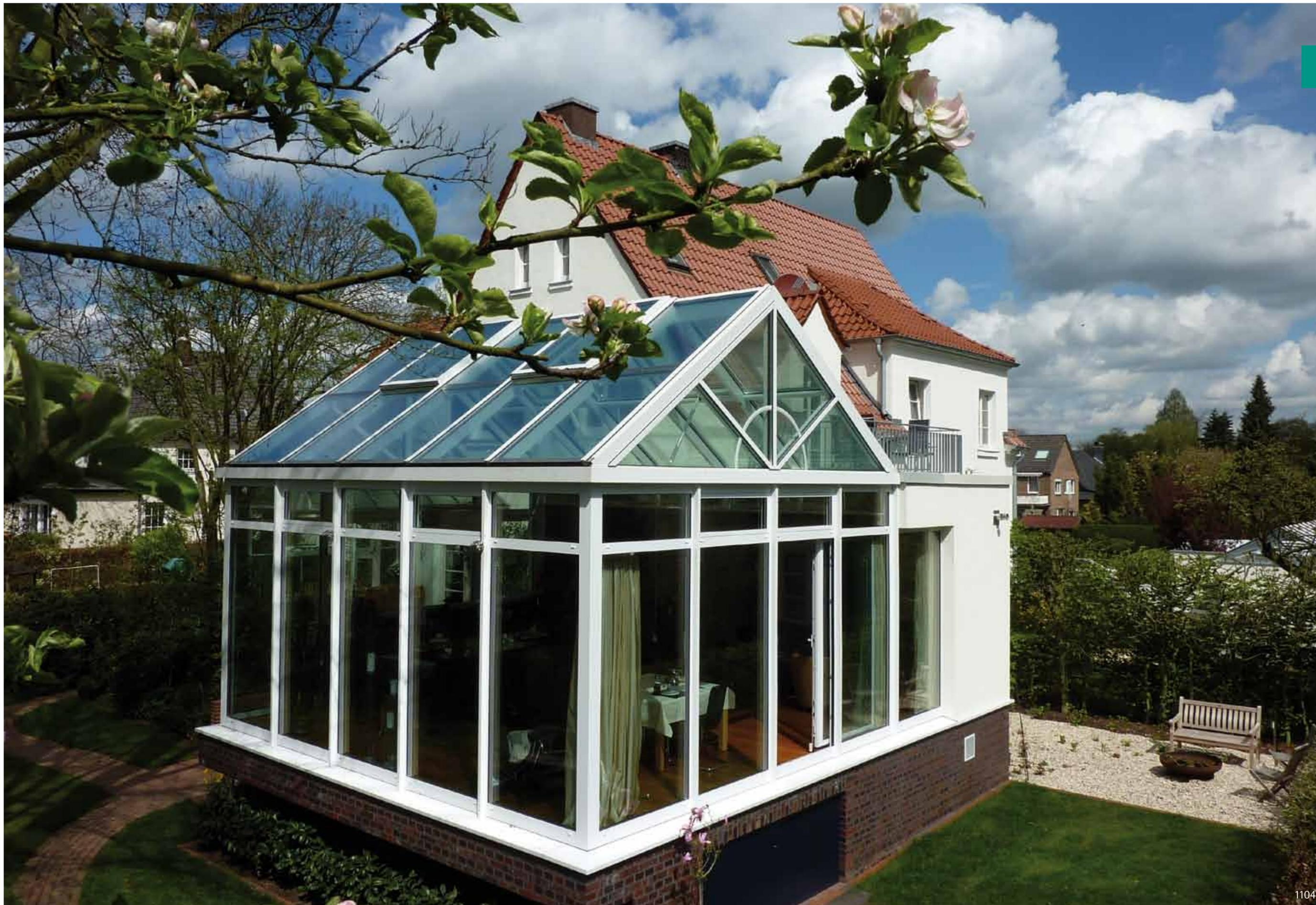
Sonnenschutzglas und Dachlüftungsfenster dienen der sommerlichen Klimaregulierung
